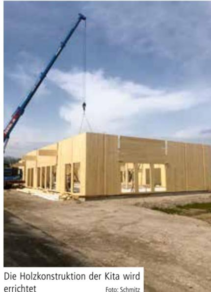
Die Holzkonstruktion der Kita wird errichtet
