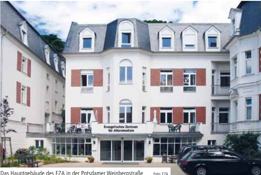
Das Hauptgebäude des EZA in der Potsdamer Weinbergstraße
