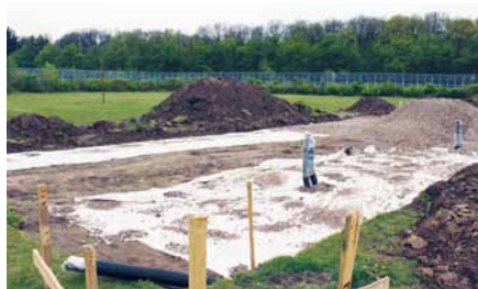
Die ersten Kubikmeter Erde sind bewegt: Baustart für den Schweinestall Foto: Echelmeyer
