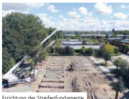
Errichtung der Streifenfundamente
