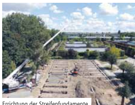
Errichtung der Streifenfundamente
