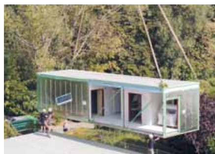
Aufbau der einzelnen Container mit bereits vorgefertigter Elektro- und Sanitärinstallation
