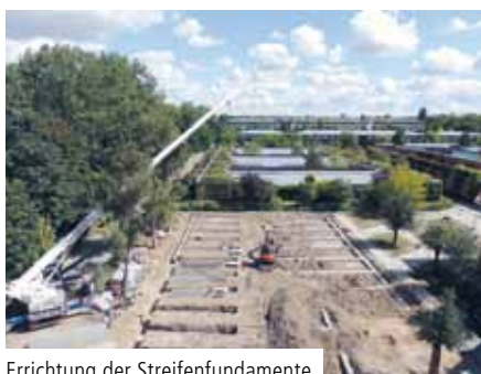
Errichtung der Streifenfundamente
