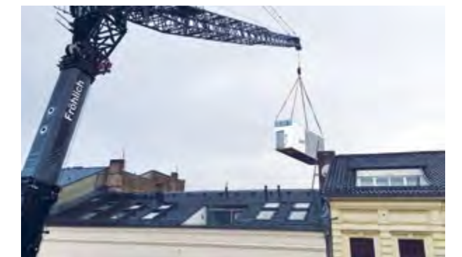
Ein ehemaliger OP über den Dächern Berlins
