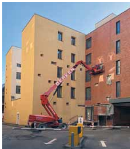
Vorbereitende Kranarbeiten für die Balkonanlage
