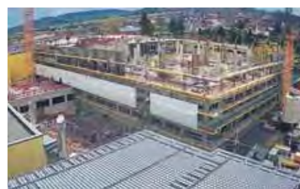
Blick auf den Bau im April 2021 Foto: Klinikum Hochsauerland
