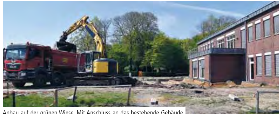
Anbau auf der grünen Wiese. Mit Anschluss an das bestehende Gebäude entstehen neue Räumlichkeiten für die Pflegeausbildung
