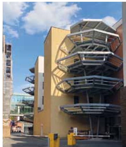
Die ersten Balkone sind befestigt
