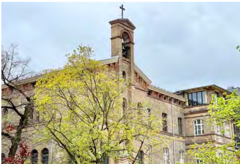
Die Sanierung des historischen Josefs-Hauses am Park Sanssouci geht in eine neue Phase
