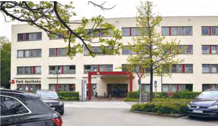
Das Facharztzentrum Krefeld ist ein wichtiger Anlaufpunkt für Patienten aus Krefeld und Umgebung, die fachärztliche ambulante Versorgung benötigen. Das Haus beinhaltet auch eine leistungsstarke Apotheke, eine Logopädie-Praxis und ein Hör-Akustik-Geschäft Foto: Jezziński
