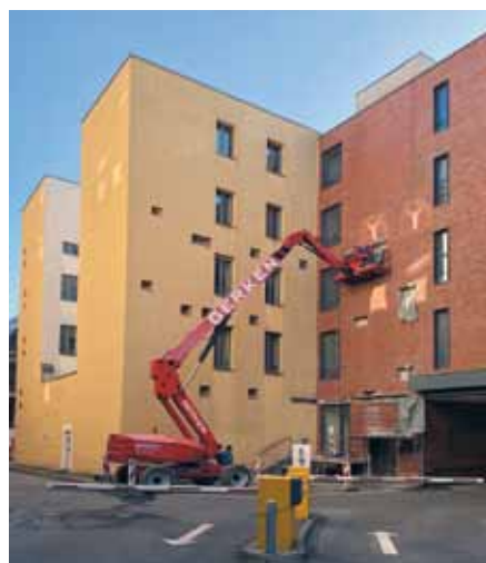
Vorbereitende Kranarbeiten für die Balkonanlage
