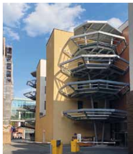
Die ersten Balkone sind befestigt
