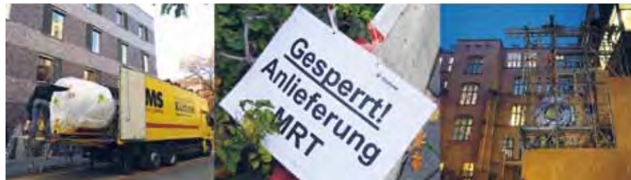
Eindrücke vom MRT-Einbau im St. Hedwig-Krankenhaus
