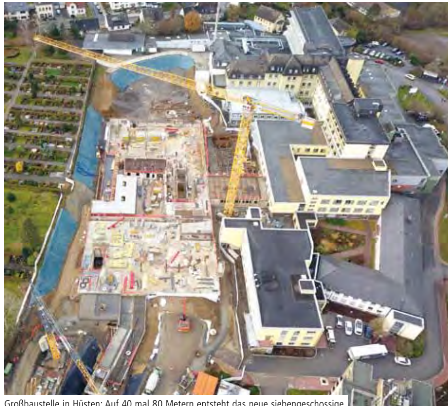
Großbaustelle in Hüsten: Auf 40 mal 80 Metern entsteht das neue siebengeschossige Notfall- und Intensivzentrum am Standort Karolinen-Hospital Foto: Klinikum Hochsauerland
